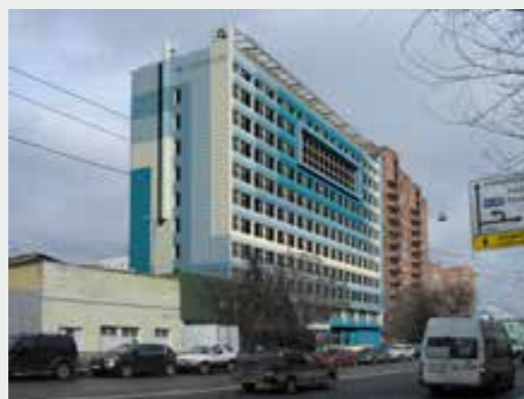
ОАО «Атомэнергопроект» центральный офис. Предприятие Госкорпорации «Росатом».
